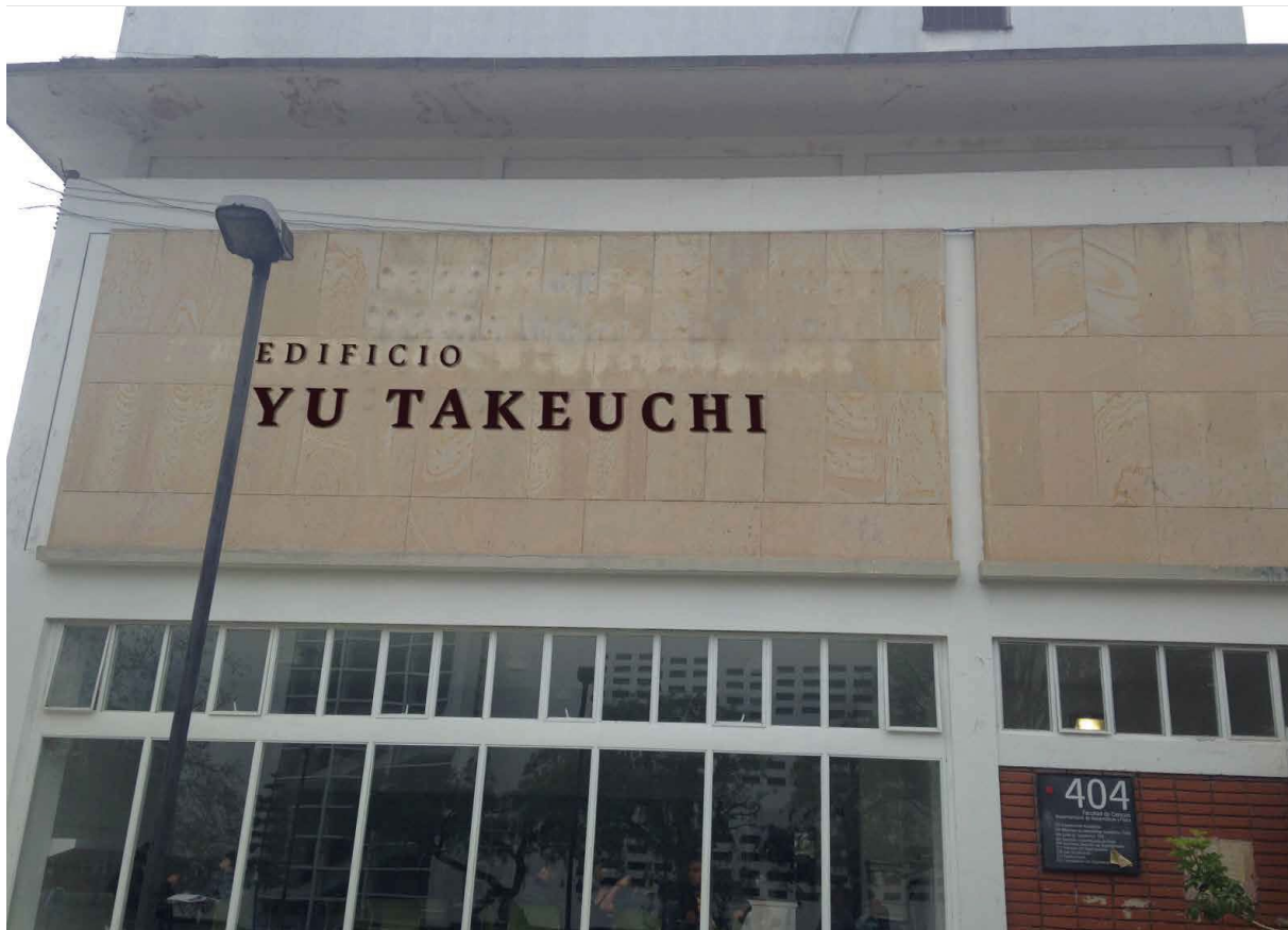
Fotografía No. 1 Montaje digital para evaluación de tamaños en fachada principal del Piloto No. 1 EDIFICIO YU TAKEUCHI.
