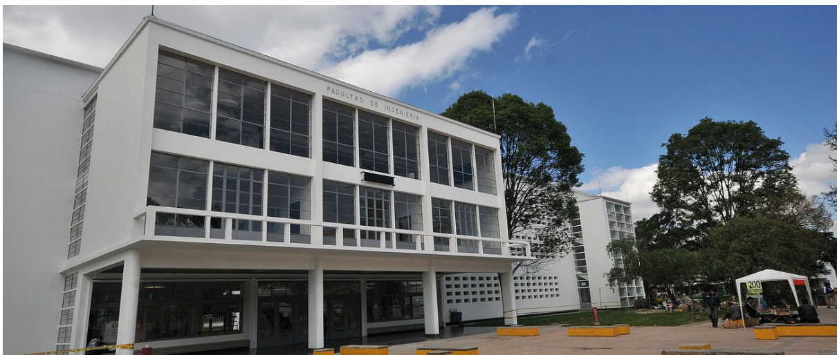
Fotografía No. 14 Fotografía real de fachada, estado inicial previo a la demarcación y renombramiento del Piloto No. 2 EDIFICIO 401 FACULTAD DE INGENIERÍA.
